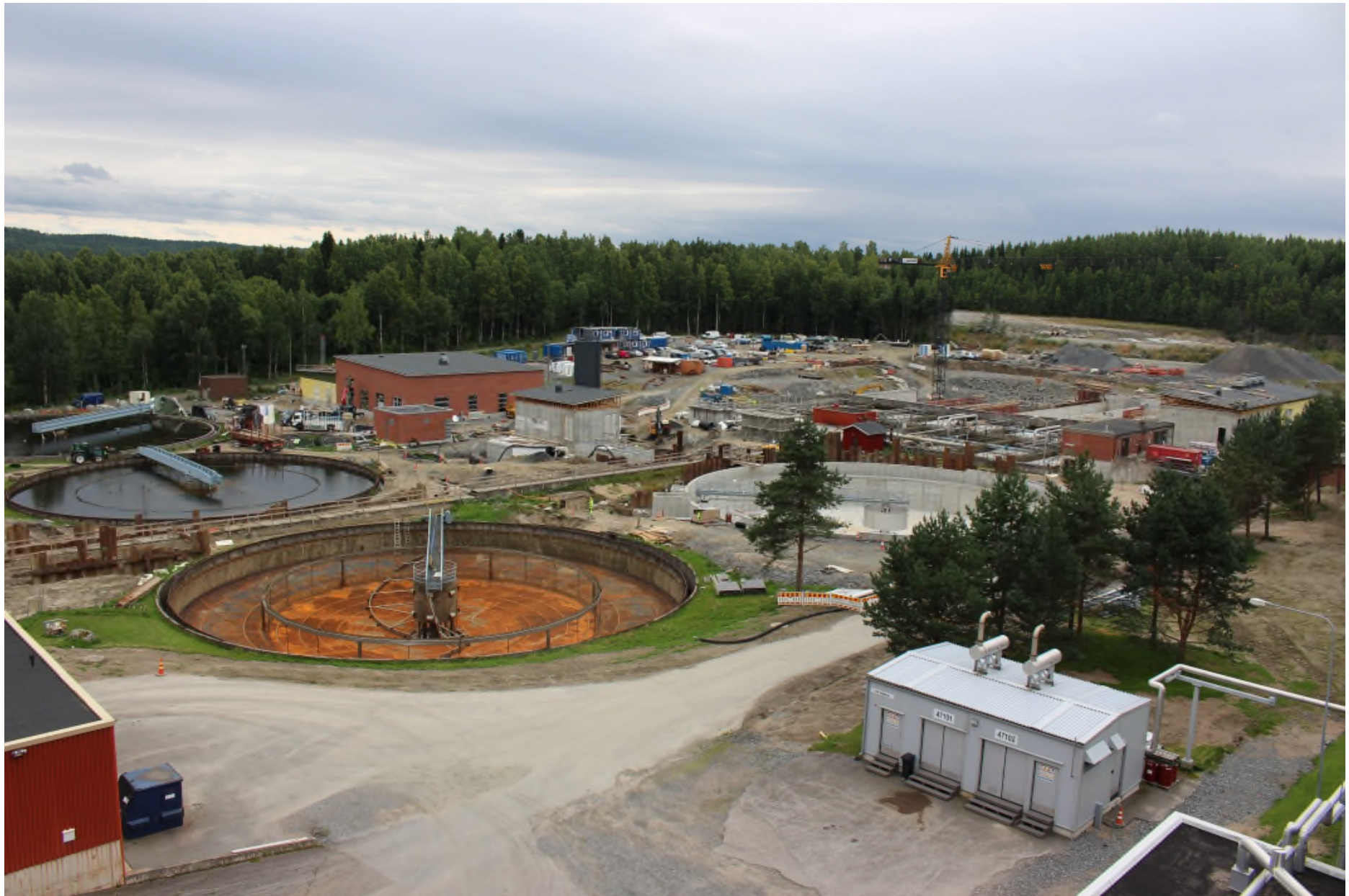
Nenäinniemen jätevedenpuhdistamo syksyllä 2017
