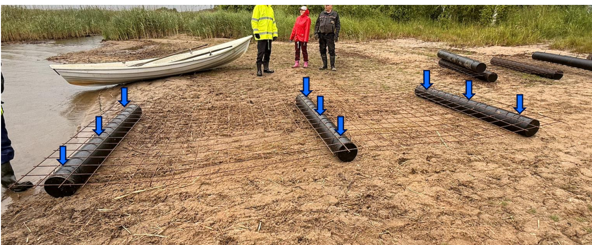
Kuva 2. Kosteikkolautta käännetään ympäri ponttonien kiinnityksen jälkeen (© Sanni Leskinen). Johdinsiteiden kiinnityskohdat merkattu kuvaan sinisillä nuolilla.
