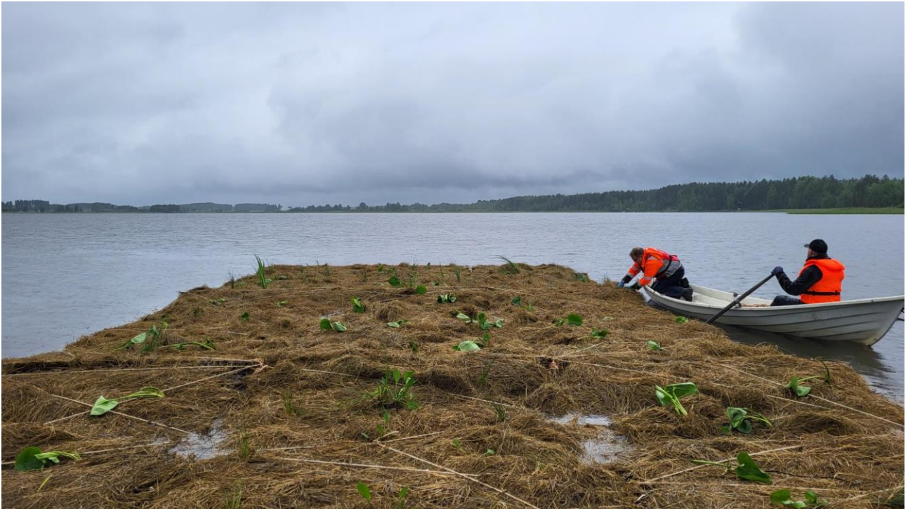
Kuva 9. Kosteikkolauttayksiköiden kiinnittämistä toisiinsa järvellä (© Tiina Kontio).
