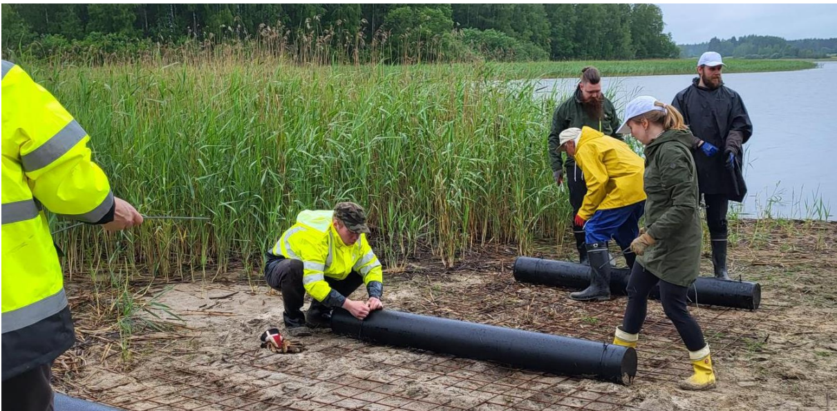
Kuva 1. Ponttonien kiinnitystä raudoitusverkkoon (© Tiina Kontio).
