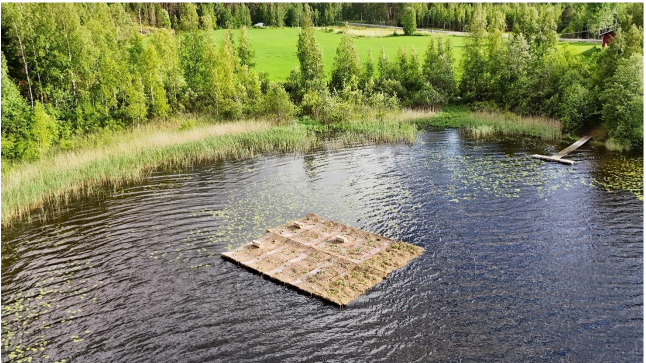
Kuva 10. Valmis kymmenen kosteikkoyksikön kosteikkolautta ankkuroituna järvelle (© Tiina Kontio).
